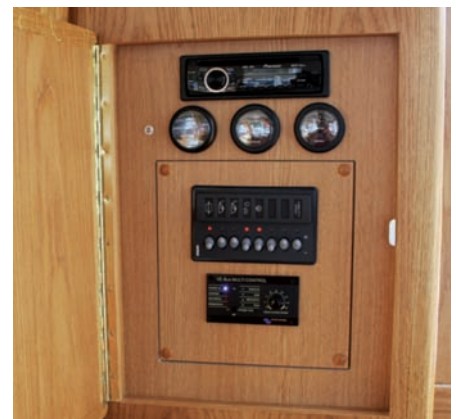
Übersichtliches Elektropaneel mit Radio.
