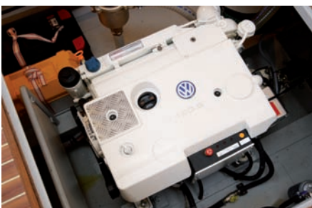
Super-saubere Installation des 5-Zylinder-VW-Diesel unter dem Salonboden.
